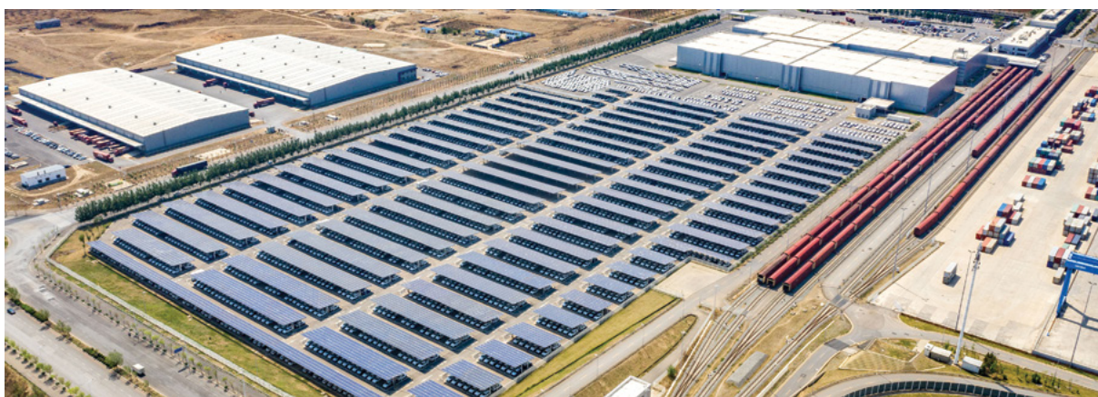
铁西工厂太阳能电池板。
